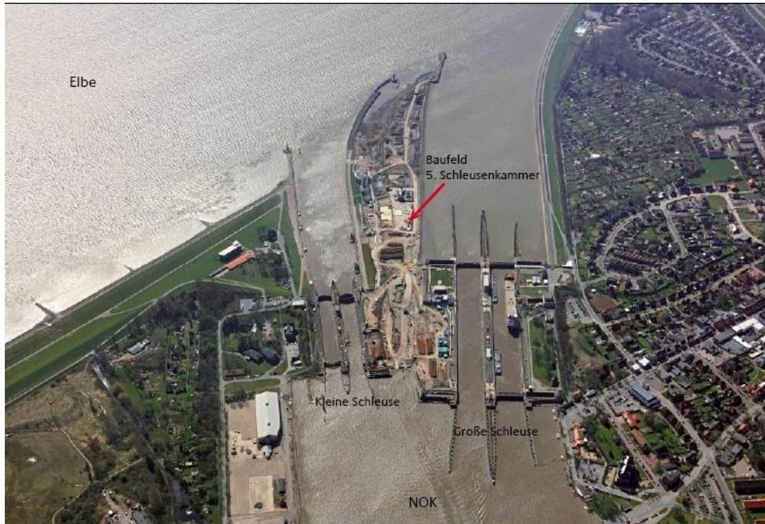
Abbildung: Schleusenanlage Brunsbüttel, Quelle: WSA Brunsbüttel
